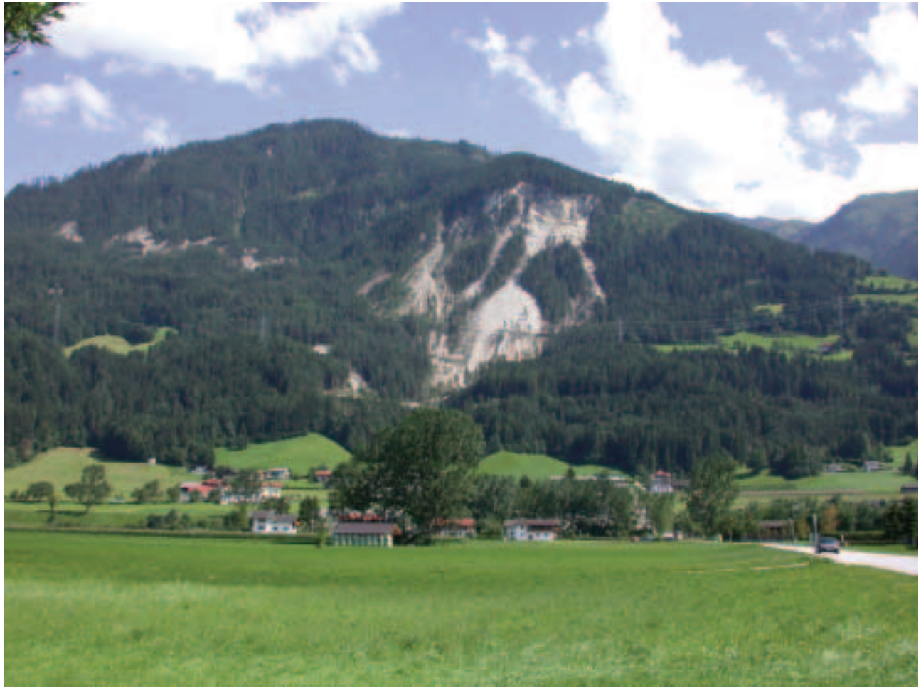
Fig. 2 Sturzgebiet am Eiblschrofen oberhalb des Ortteils Ried bei Schwaz (Foto: MEISSL, August 2002)
