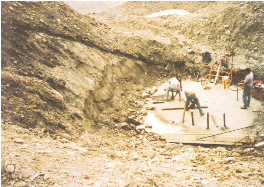
Da die direkte Beobachtung von Permafrosteis in der Regel nur nach größeren Erosionsprozessen oder bei tiefgründigen Baggarbeiten möglich ist (siehe Abb. 7), beruhen die Aussagen zur gegenwärtigen Verteilung des Permafrostes im Oberen Suldental auf der Kartierung und Interpretation von Leitformen wie Blockgletschern,
